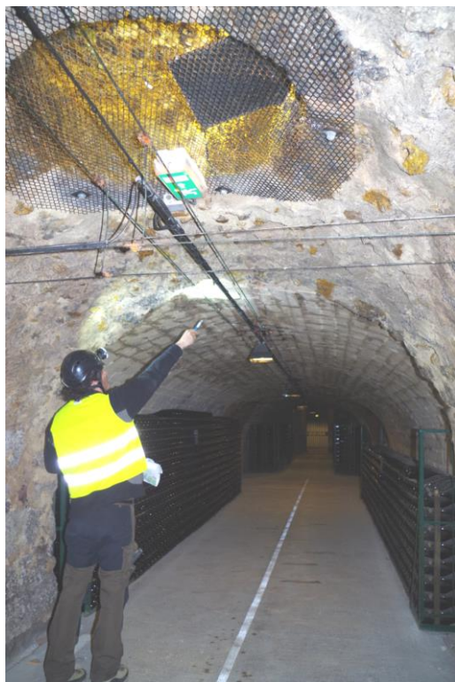
Caveau dédié à l'entreposage du Champagne
